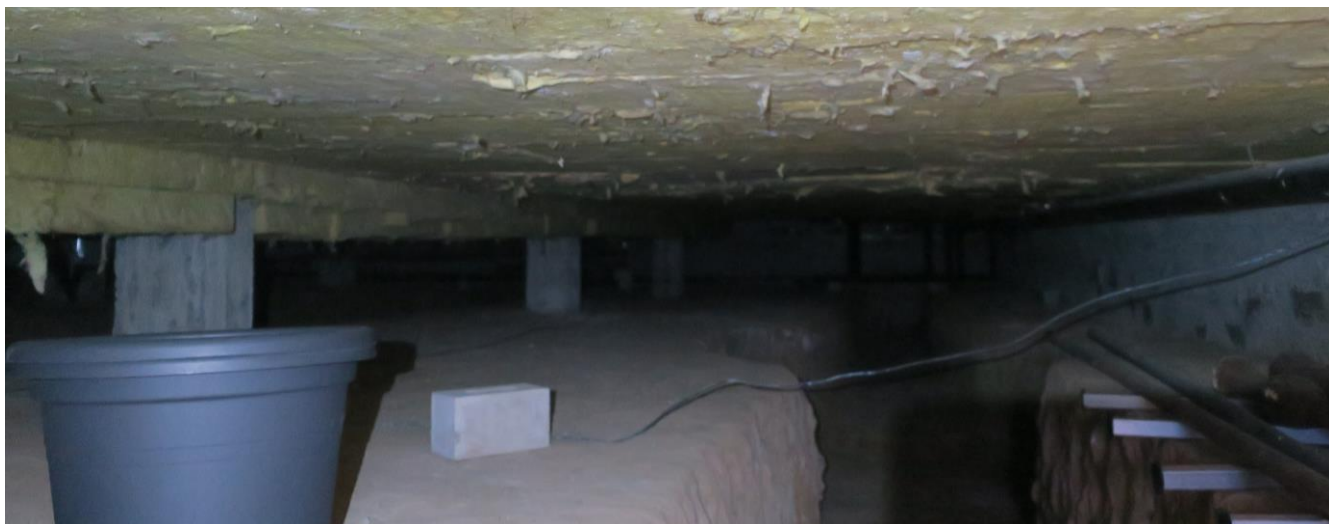
Abbildung 8: Isolation der Kellerdecke unter der Kirche. Foto: Simone Fopp
